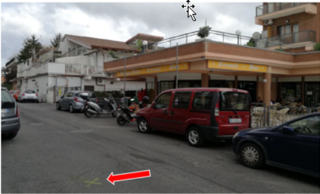
Leck in der Hauptleitung in Via di Bentivoglio Höhe Hausnummer N. 30
