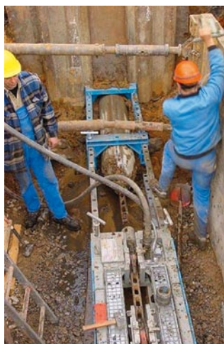
Posa di condotte senza scavo con tubi vonRollcopur.
